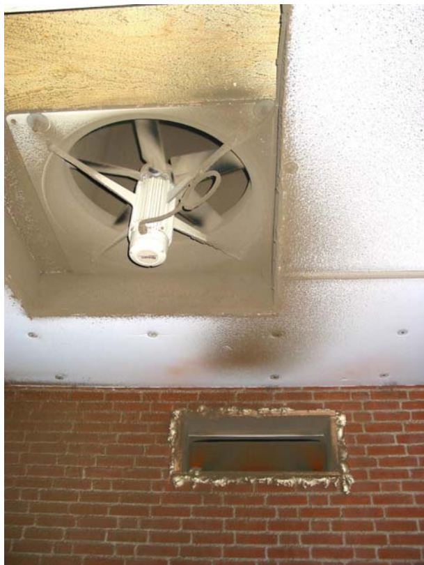
Foto: De lucht afkomstig uit de stal (zie luchtuitlaat in de muur) wordt door een ventilator langs onder in de luchtwasser geduwd.
