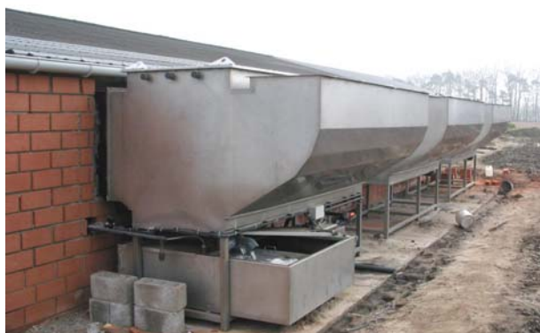
Foto: Drie chemische luchtwassers in opbouw.
